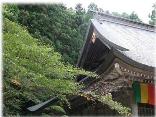
山形市山寺 根本中堂の庇（6月撮影）
